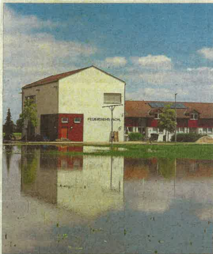
Stand auch am Dienstag noch unter Wasser: Das Feuerwehrhaus in Pichl. Im Vordergrund der geflutete Sportplatz. Foto: Schmidtner
